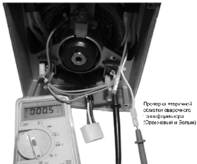
Рисунок 4. Проверка вторичной обмотки сварочного импеданса
